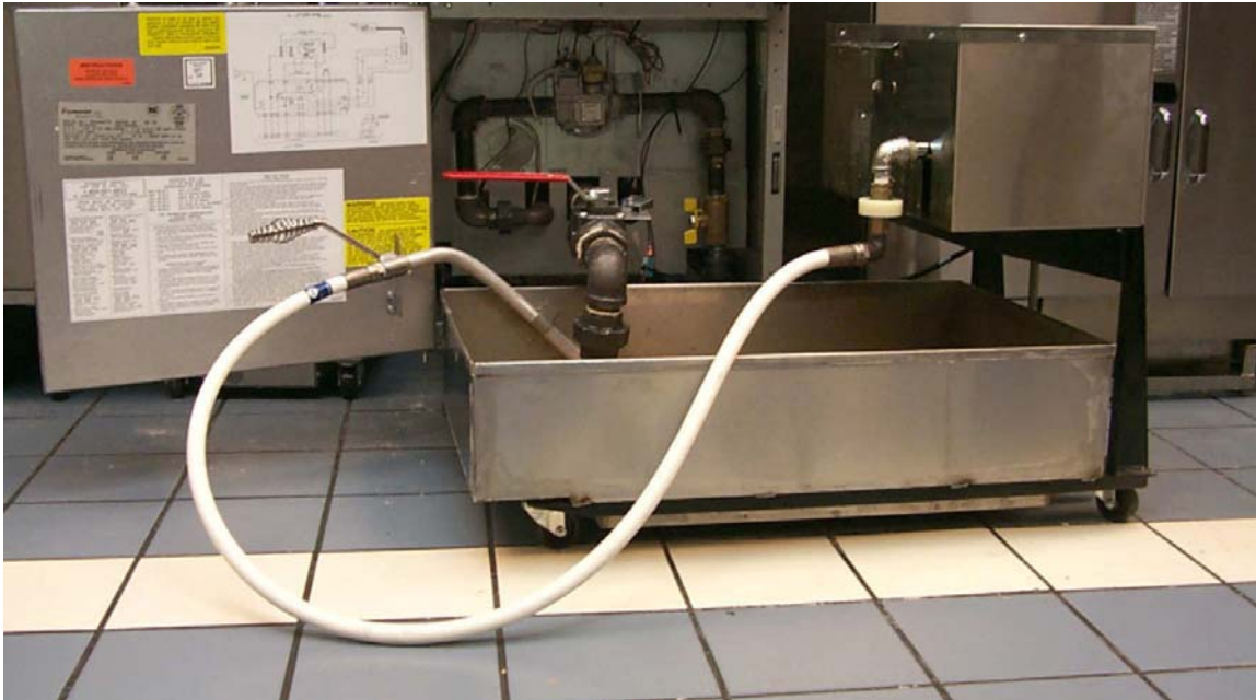
Filtro portátil PF95LP correctamente colocado al lado de la válvula de drenaje de la freidora, con las ruedas traseras bloqueadas.
